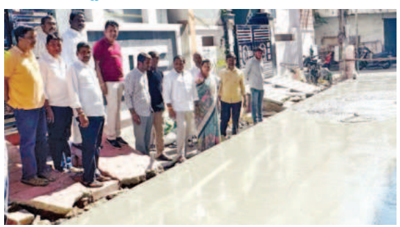
సిసి రోడ్డు పనులు పరిశీలిస్తున్న కార్పొరేటర్ గోపవీణ్ తదితరులు
